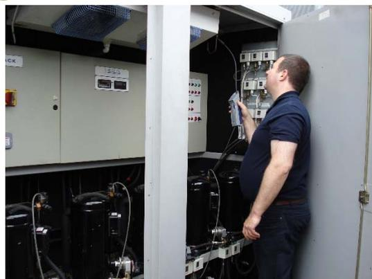
Con todos los métodos es importante realizar el ensayo metódicamente, comprobando cada una de las piezas del sistema, incluidas las conexiones del presostato o las líneas de descarga de las PRV. Se deben encontrar todas las fugas —la primera fuga probablemente no será la única.
